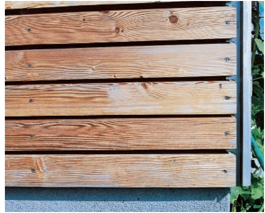
Fassadendetail Lärchenschalung
