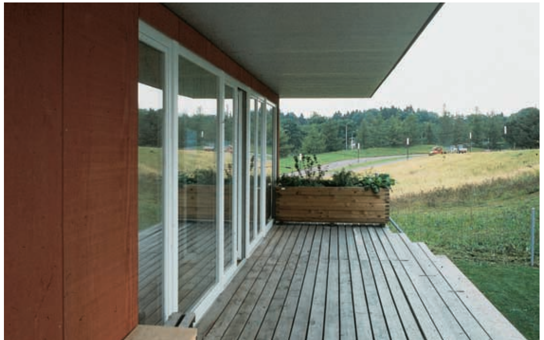
Bild 8 Durch weitauskragendes Vordach sehr gut wettergeschützte Holzfenster, Fassadenverkleidungen aus Sperrholz und Terrassenrost. Kräftig rot pigmentierte Dünnschichtlasur bzw. deckend weiss pigmentierter Fensterlack. Kinderkrippe ETH-Hönggerberg, Zürich.
