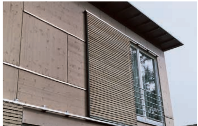
Fassadendetail mit Schiebejalouse und sorgfältig ausgebildetem Kantenschutz
