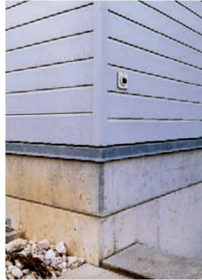
Fassadendetail am Fuss des Gebäudes
