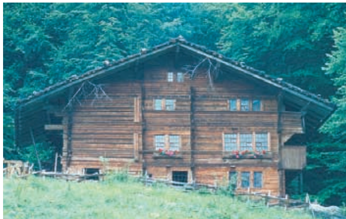
Bild 2 Südfassade eines Bergbauernhauses in Adelboden (BE) (Blockbau) aus unbehandeltem Fichtenholz, Baujahr 1698. Heutiger Standort ist das Freilichtmuseum Ballenberg. Der sehr gute bauliche Holzschutz durch das Vordach sowie das eher trockene Klima bewirkten eine gleichmässig braune Verfärbung des Holzes.
