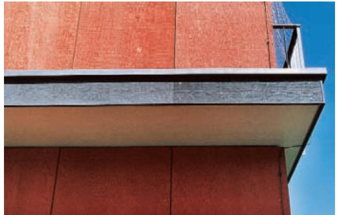
Fassadendetail mit Strimabdeckung
