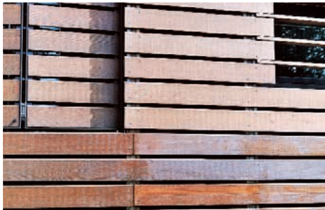
Detail der renovierten Oberflächenbehandlung
