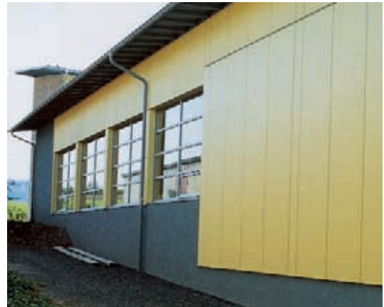
Gesamtansicht Ost (Dreischicht-Massivholzplatten)
